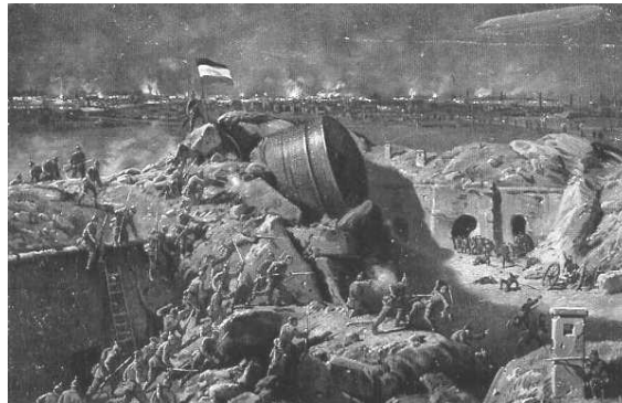
Destruction des forts de Liège Collection privée
