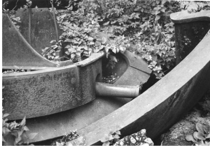
La coupole de droite du saillant II renversée par l'explosion du 15 août 1914 (photo de 1977).
